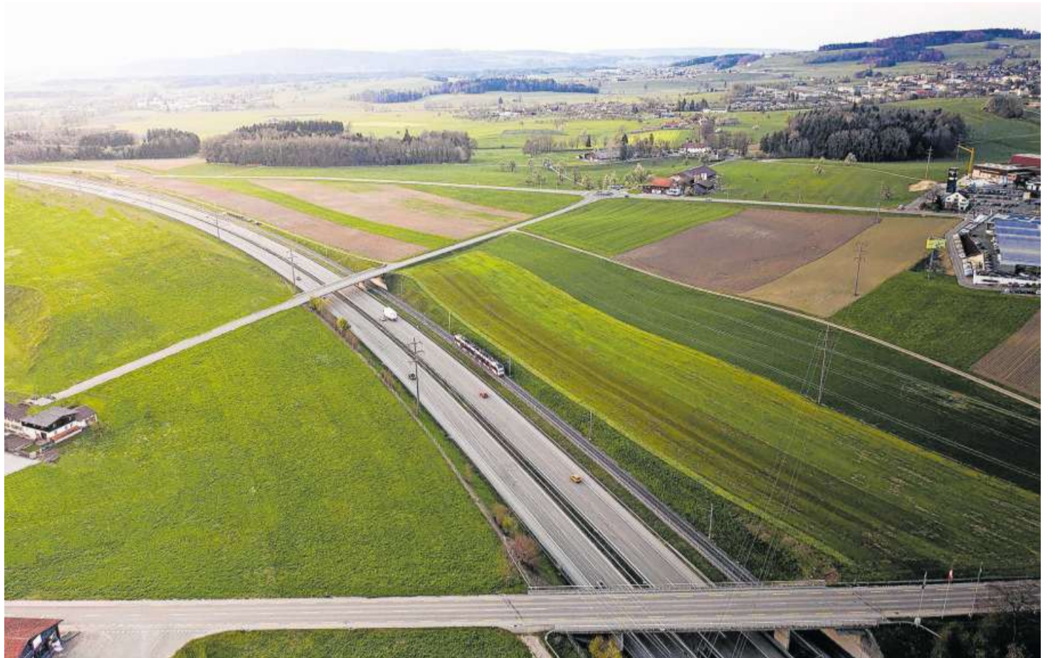
Mit dem Wirtschaftsstandort Wil West sollen 3000 Arbeitsplätze auf einem Areal in Sirmach und Münchwilen entstehen.
